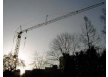
20.03.2006: Der Baukran steht.
