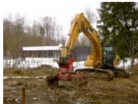
03.03.2006: Der Bau beginnt!
