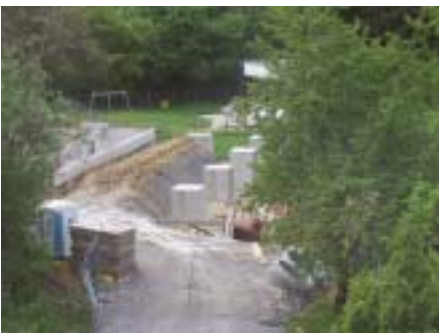
21.05.2006: Fundamente des Bürgerbereichs.
