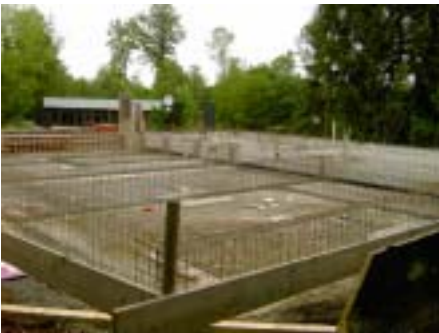
20.05.2006: Bodenplatte des KITA Bereichs.
