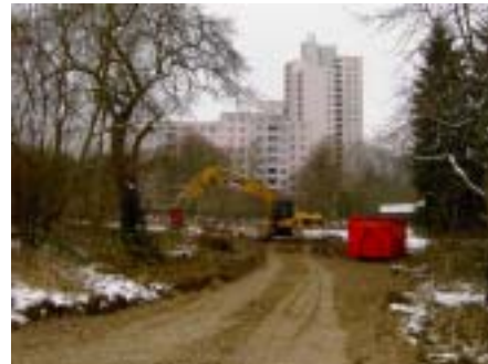
03.03.2006: Der Bagger ist angerückt.
