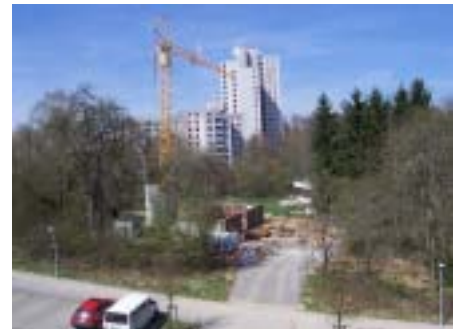
24.04.2006: Einige Wände im UG stehen.
