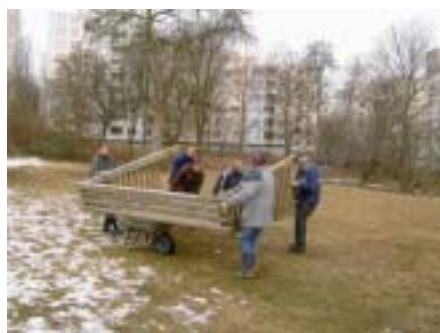
Versetzen der Bolzplatztore
