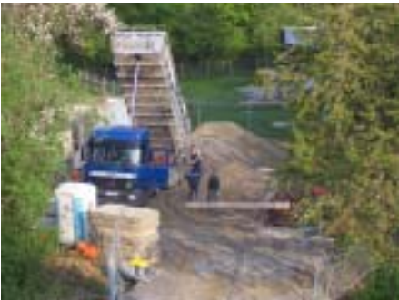
10.05.2006: Fundament wird aufgeschüttet.
