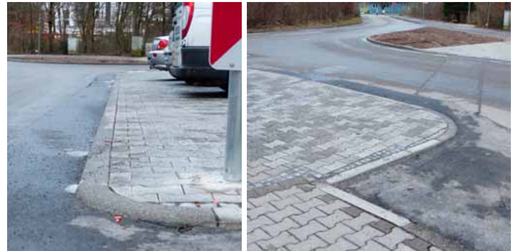
Problem abgesenkter Randstein: Der abgesenkte Randstein führt zusammen mit der Struktur der Pflastersteine dazu, dass der Gehweg vermeintlich als Parkfläche wahrgenommen wird.
